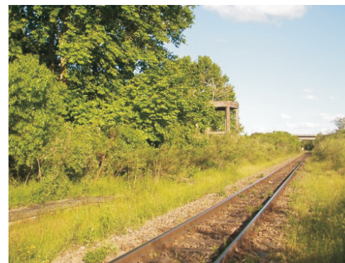
Estação Ferroviária em Azevedo Sodré
